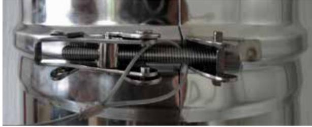
**3.** Sicherungssseil der Regenhaube am Verschluss des Klemmbandes befestigen.
