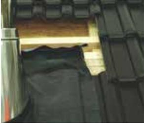
**5.** Firstseitig; Ablängen einer Dachlatte und diese 5 cm unterhalb der WAKAFLEX Oberkante festnageln. Seiten- und Oberkante einfalten und eine Wasserrinne zu bilden. Im Anschluss WAKAFLEX auflegen am Sparren mit Nägeln mittig, links und rechts fixieren.
