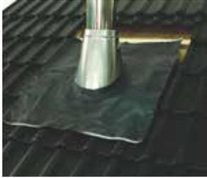
**2.** Dachdurchführung WAKAFLEX überstülpen und gemäß den jeweiligen Dachdeckerrichtlinien in die Dachkonstruktion einbinden (Spengler).
