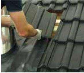
**6.** Dachziegel passend zur Form des Kegels der Dachdurchführung zuschneiden und obere Reihe montieren.
