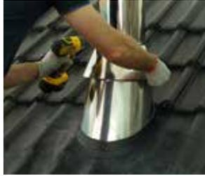
**7.** Regenkragen oberhalb der Dachdurchführung am Rohrelement versetzen und kraftschlüssig verschrauben.
