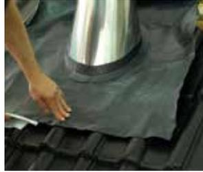
**4.** Entfernen der Folie an der WAKAFLEX Unterseite. Material leicht an die Dachziegel andrücken und anformen. Für eine dichte Verbindung fest mit der Rolle nachdrücken.
