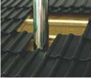
**1.** Abgasanlage durch das Dach führen. Oberhalb der Anlage eine Reihe Dachziegel abgedeckt. (Erforderlicher Abstand zu brennbaren Bauteilen, siehe Planungshinweise).
