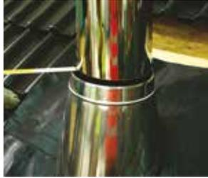
**3.** Zentrieren der Dachdurchführung zur Abgasanlage (gleich grosser Spalt rundum). Die Dachdurchführung gleichmäßig und waagrecht zur Rohrsäule ausrichten.
